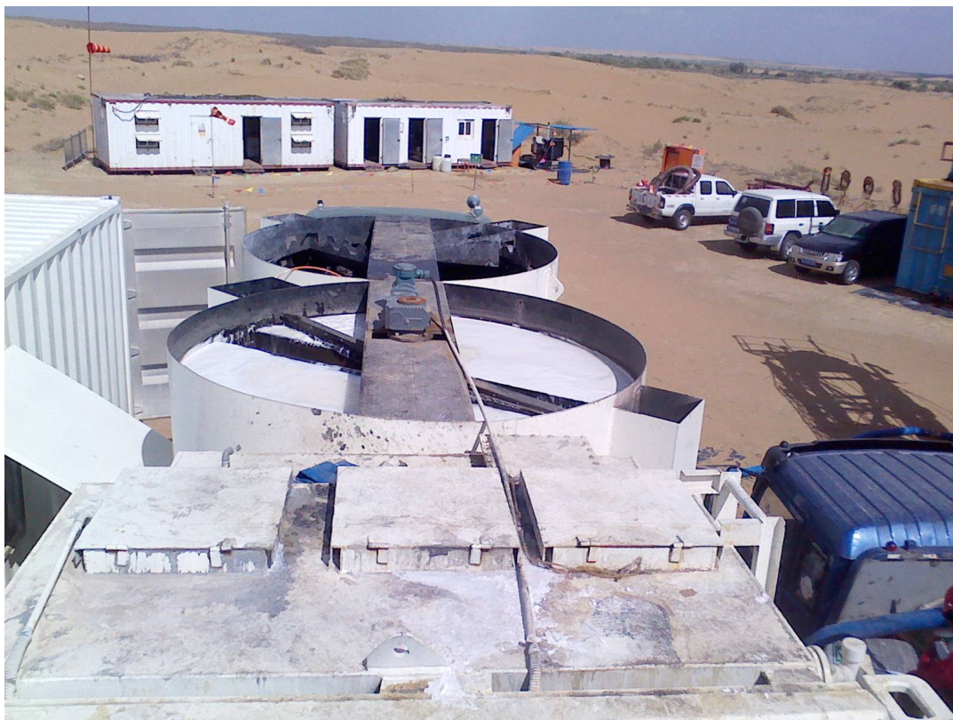
装置现场就位：开始运行
