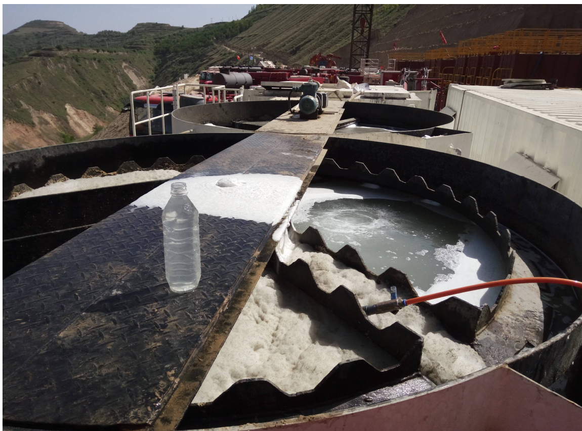
预处理装置出水水样
