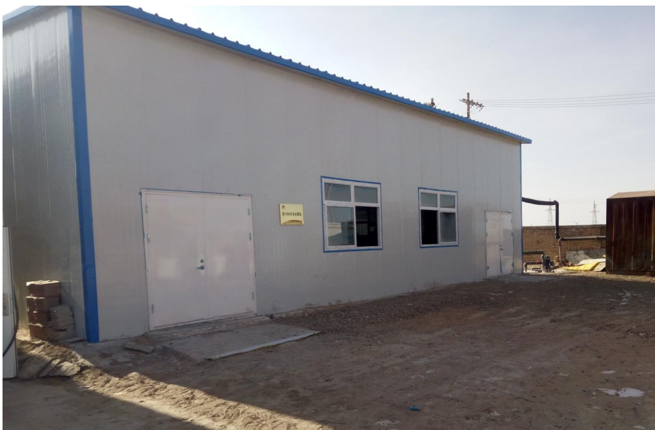
定1368污水处理站
