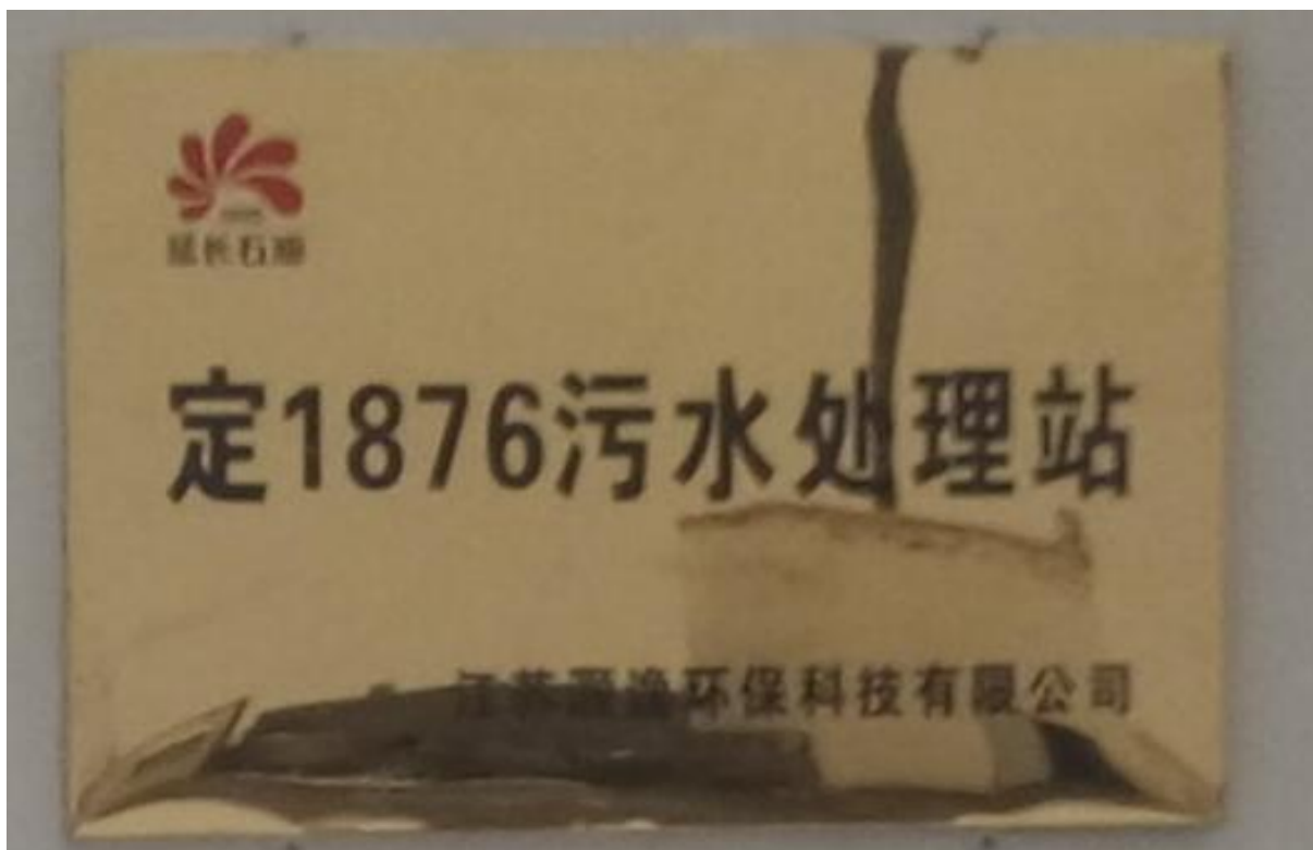
定 1876 污水处理站厂牌
