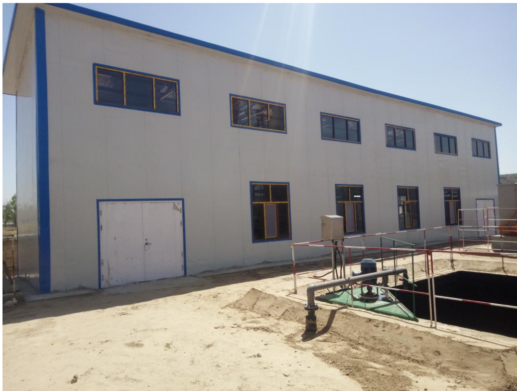
卸污池、污水提升泵
