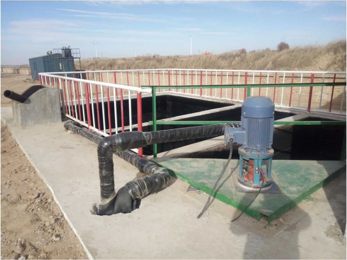
定 2642 污水站：新建卸污池、污水提升泵
